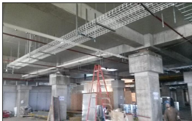
Alcantarillado bajo losa en sector CDT
