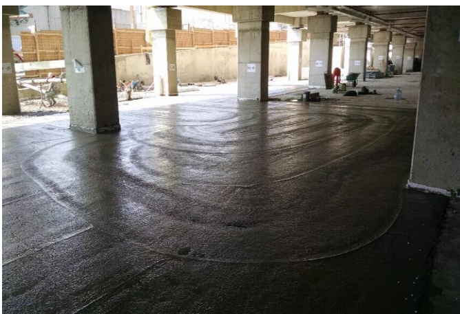
Avance de radier en edificio CDT
