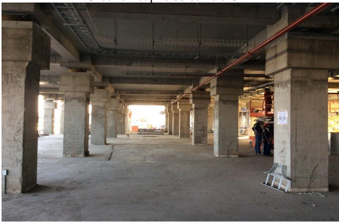
Avance losa hormigonada en edificio UPC
