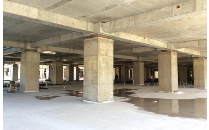
Dispositivos instalados en edificio TH
