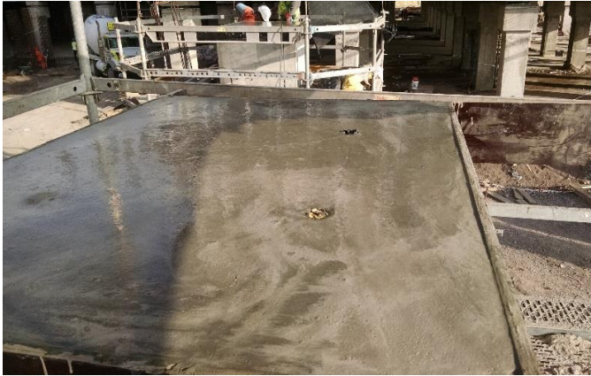
Grout en capiteles edificio CDT
