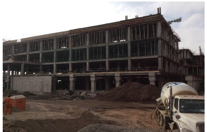
Avance en la colocación de hormigón en edificio Unidad de Pacientes Críticos UPC
