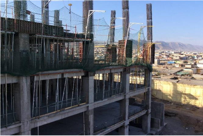
Avance enfierradura Torre Hospitalización TH
