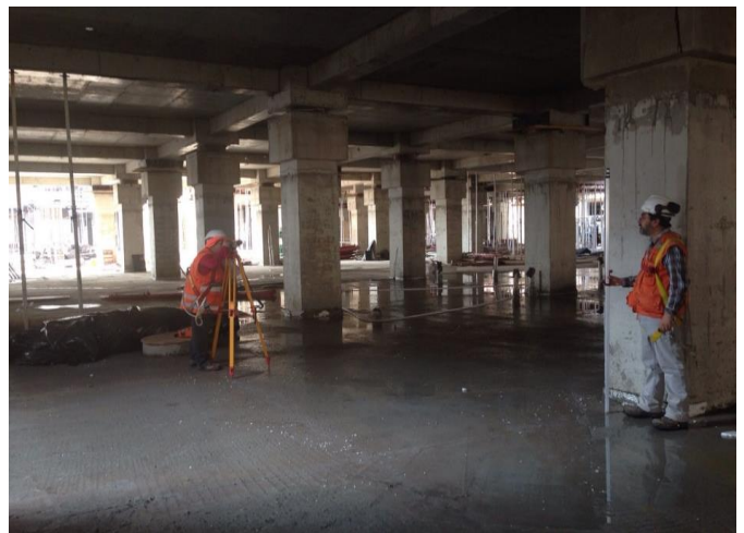
Control topográfico para toda la obra
