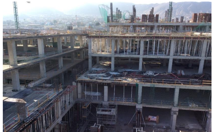
Avance en la colocación de hormigón en Centro Diagnóstico Terapéutico CDT
